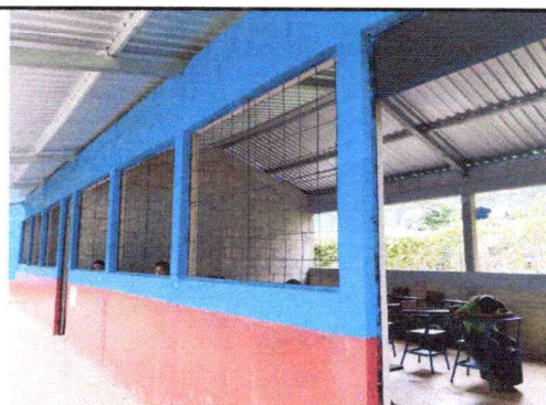
Foto 4: Se visualizan los balcones colocados.
