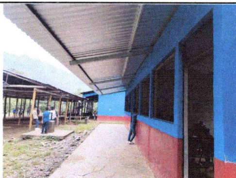
Foto 3: Vista interna del nuevo entechado.
