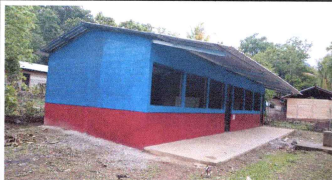
Foto1: Vista lateral de las dos aulas remozadas.
