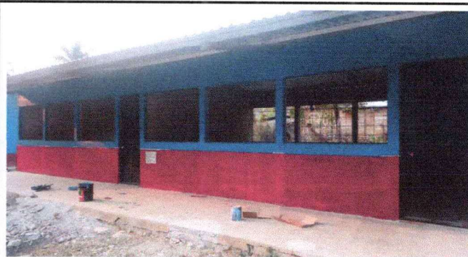
Foto 2: Vista frontal de las aulas remozadas.
